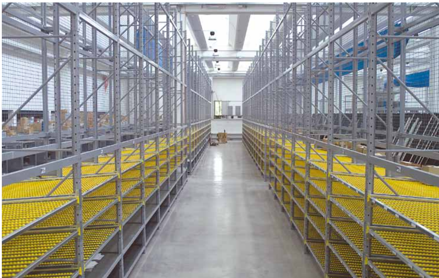
Impianto misto con rulli gravità e portapallet per deposito medicinali
