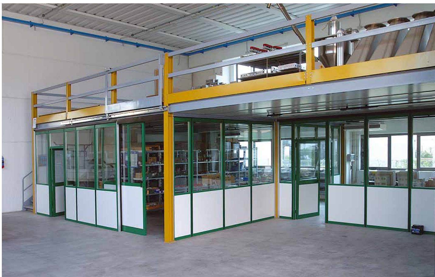
Soppalco GP con pareti uffici
